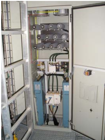
Detall filtre harmònics.
